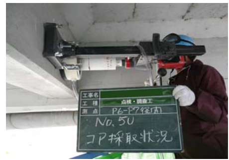
コンクリートコア採取状況
